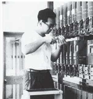
ステップ・バイ・ステップ自動交換機の動作試験を行う松前達郎先生
