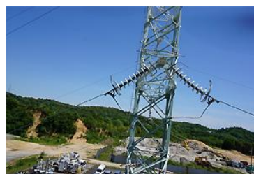
送電鉄塔の点検
